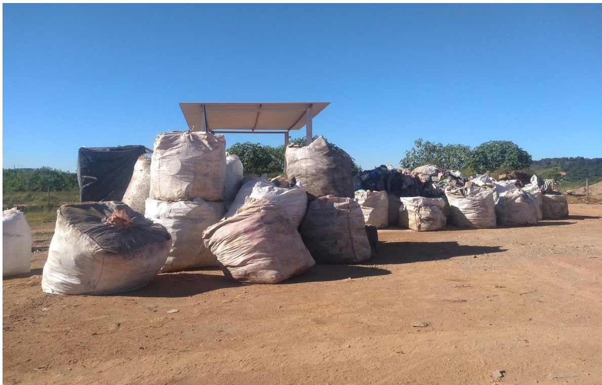
Figura 37 - Separação de material reciclável do RCC
