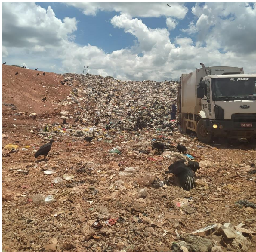
Figura 31 - Área do aterro recebendo RSU de caminhão compactador Fonte: Próprios autores, 2021
