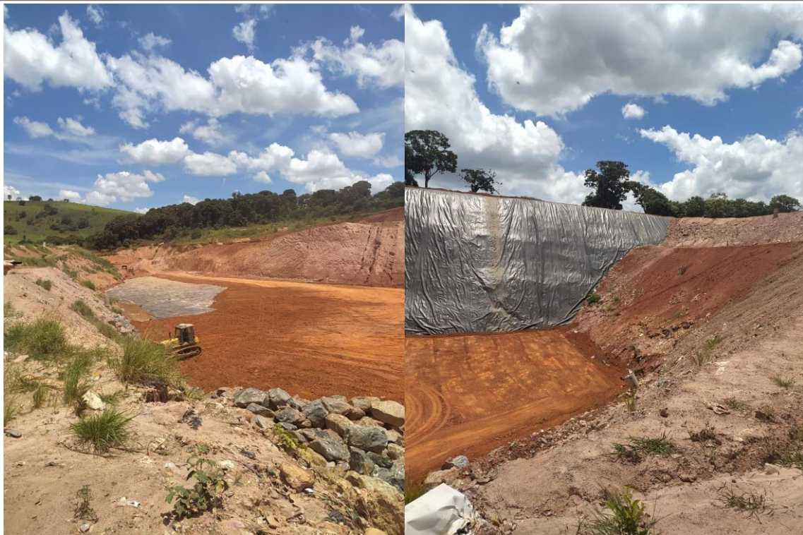
Figura 32 - Áreas do aterro impermeabilizadas para o recebimento de resíduos Fonte: Próprios autores, 2021
