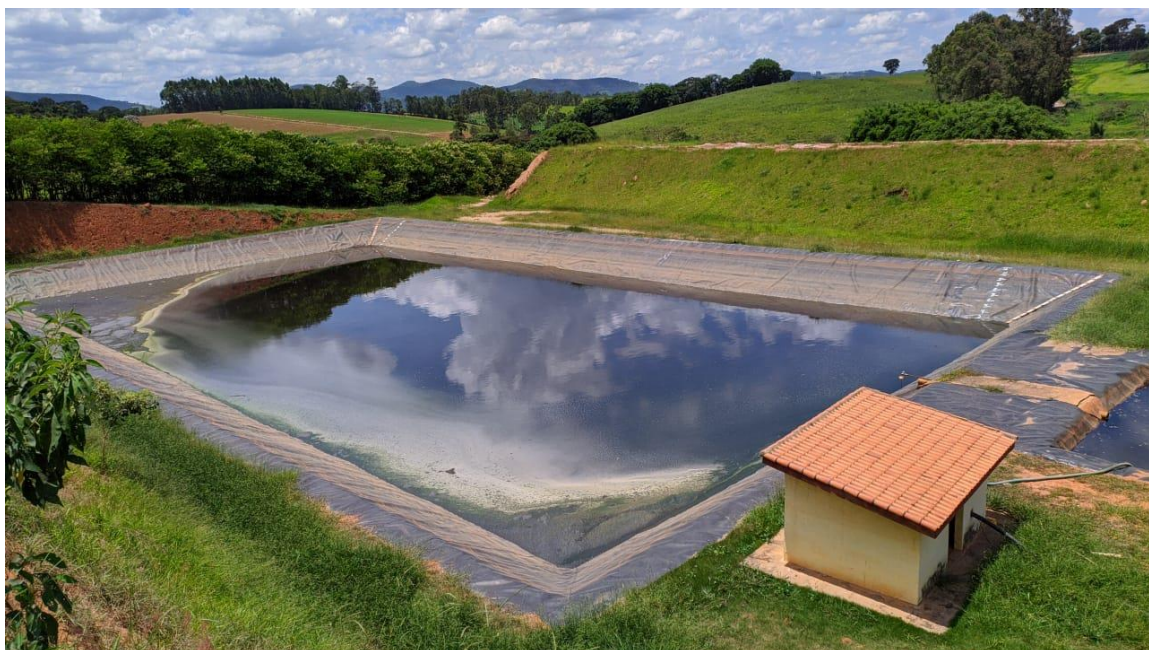
Figura 33 - Piscina reservatório de chorume do aterro Fonte: Os próprios autores, 2021
