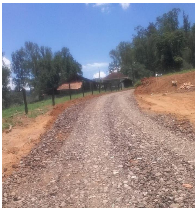
Figura 40 – Estrada Rural recuperada com beneficiamento de RCC em Pouso Alegre
